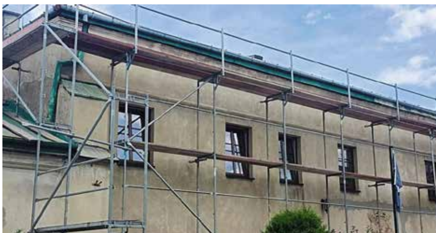
Prace przy wymianie dachu już ruszyły
