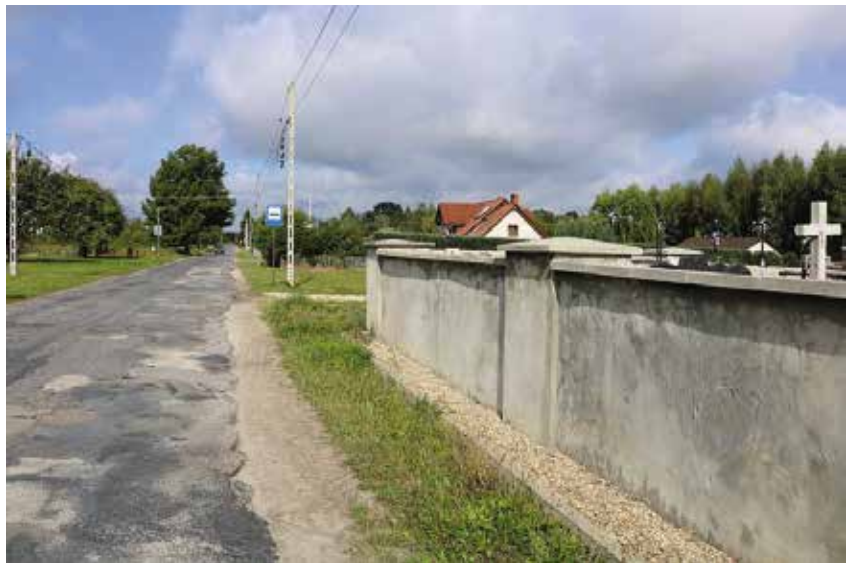
Już niebawem rozpocznie się przebudowa drogi Siedlce-Łukowa
