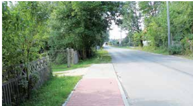
Budowa chodnika w Lipowicy będzie kontynuowana
