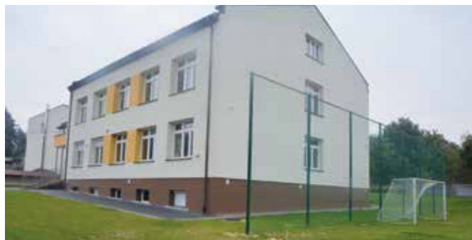
Nowe piłkochwyty zapewnią bezpieczeństwo uczestnikom gry i zabezpieczą ściany budynku przed uszkodzeniem
