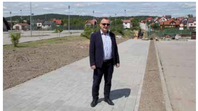
Burmistrz, Robert Jaworski na budowie drogi Al. Józefa Piłsudskiego
