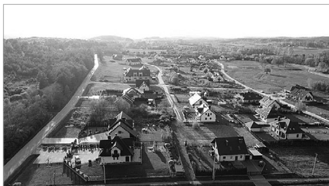
Nowe drogi powstaną na Osiedlu w Skibach
