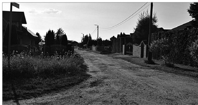
Nowa droga ułatwi dojazd do istniejących posesji i otworzy nowe możliwości pod budownictwo mieszkaniowe.
