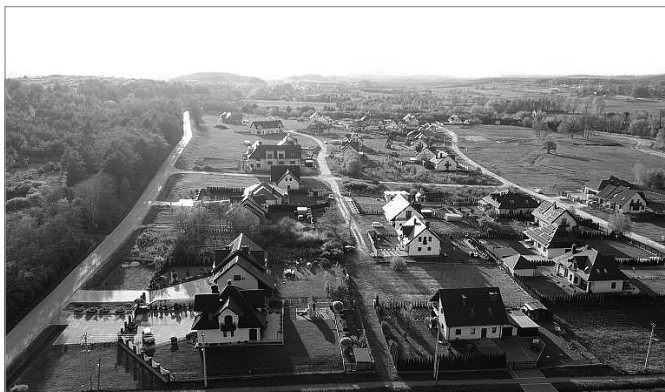
W najbliższym czasie zostanie wybudowana nowa droga na Osiedlu w Skibach
