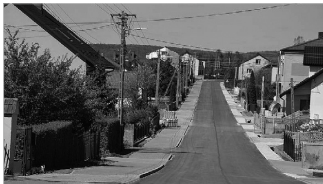
Nowa droga i chodniki powstały na długości ponad 2 kilometrów
