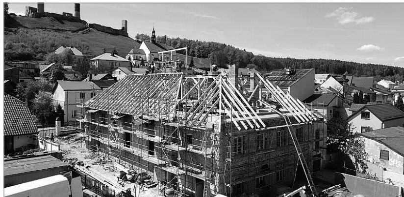
Trwają intensywne prace przy dachu na synagodze
