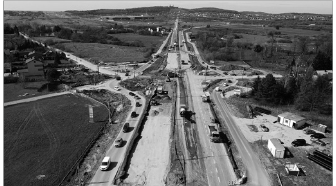
Zmiany w organizacji ruchu przy budowie ronda turbinowego
