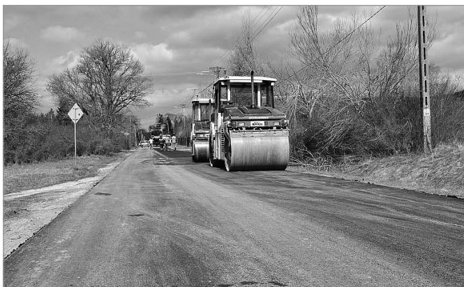
Trwają prace przy przebudowie drogi w Mostach
