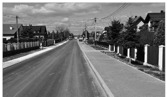
Prace przy przebudowie drogi Starochęciny-Przymiarki-Lipowica
