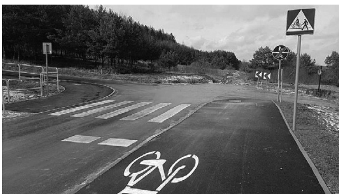
Pierwszy etap budowy został zakończony
