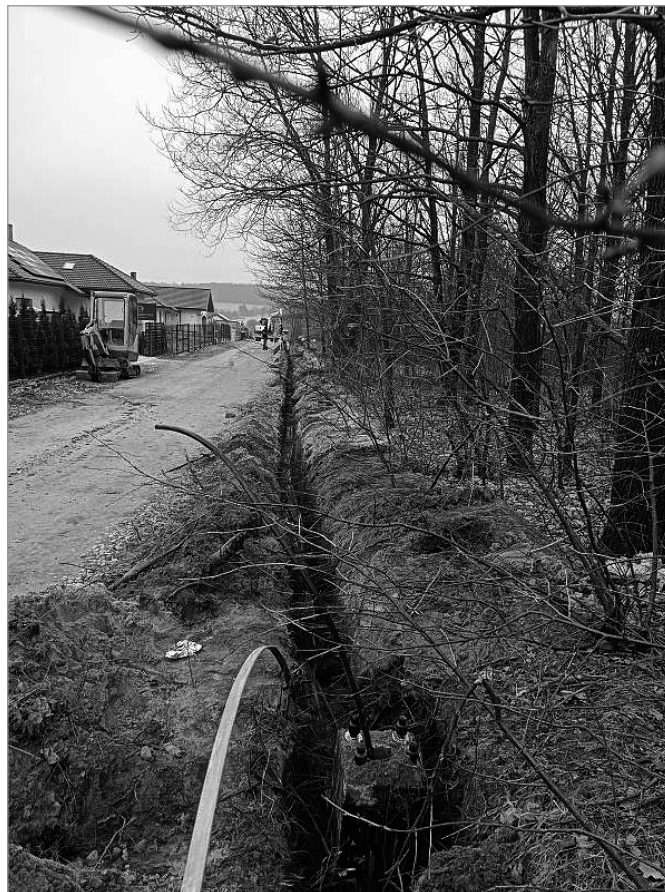
Trwają prace przy budowie oświetlenia
