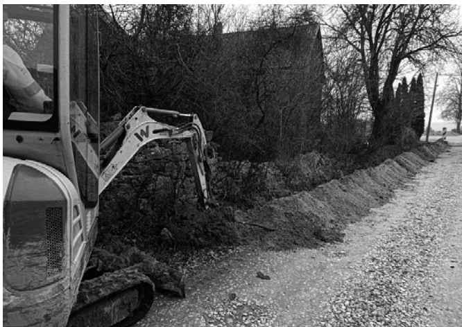
Niebawem powstanie nowe oświetlenie
