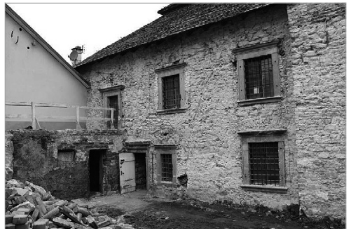
Trwa remont budynku synagogi
