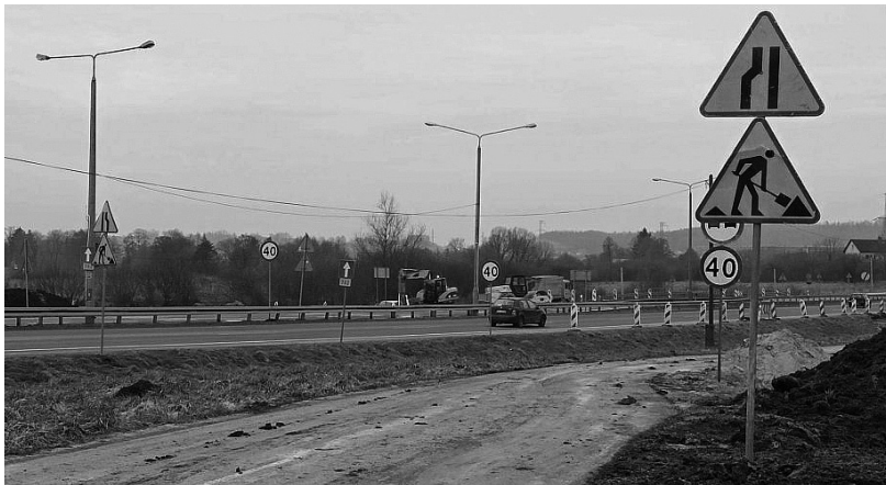
Rozpoczęły się prace przy budowie ronda turbinowego
