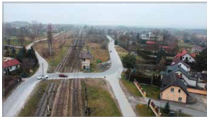
Zmodernizowane zostaną dojazdy do przejazdu
