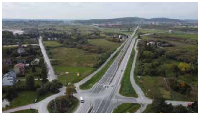
Na tym skrzyżowaniu powstanie rondo turbinowe
