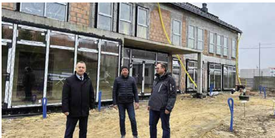
Burmistrz Robert Jaworski dogląda postępu prac przy budowie biblioteki.
