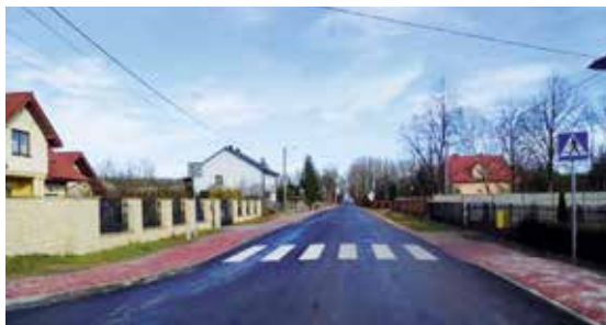
Droga i chodnik w Lipowicy już cieszą mieszkańców
