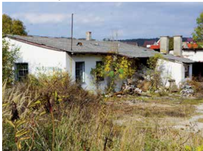
W miejscu starych, walących się budynków powstanie strefa rekreacji
