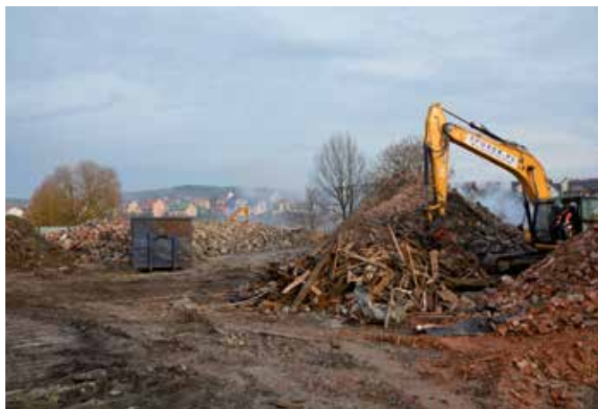
Trwa rozbiorka starych budynków i wyrównywanie terenu
