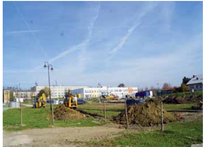
Rozpoczęły się prace przy budowie nowej siedziby dla chęcińskiej Policji
