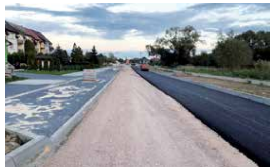
Dynamiczne prace przy budowie Alei Marszałka Józefa Piłsudskiego
