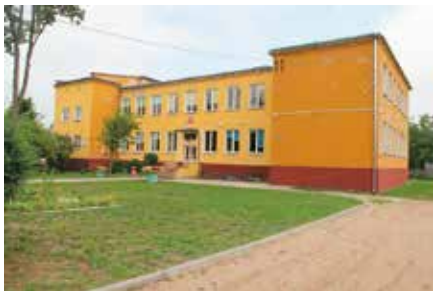
Budynek SP w Wolicy niebawem będzie wyremontowany
