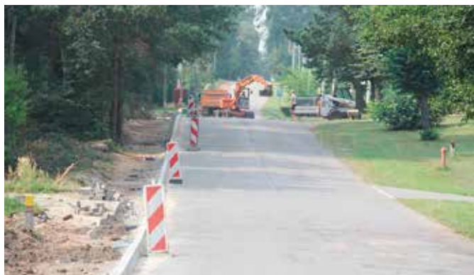
Trwa budowa chodnika w Lipowicy
