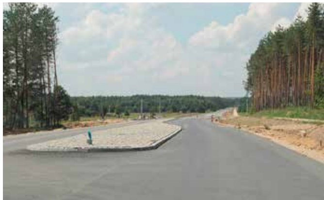
Przebudowa drogi Chęciny-Małogoszcz już zbliża się do finiszu
