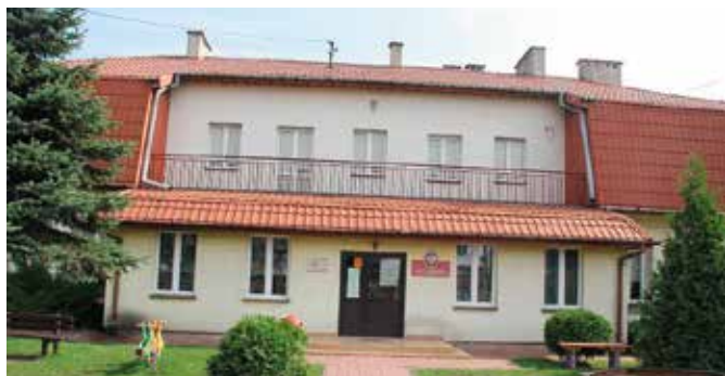
Szkoła w Radkowicach przejdzie termomodernizację
