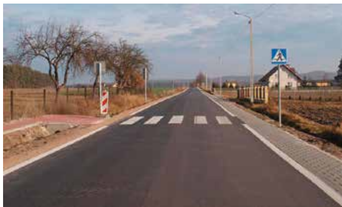
Wyremontowana droga Chęciny - Miedzianka w Polichnie
