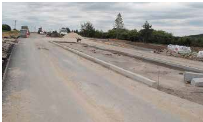
Budowa drogi wojewódzkiej nr 762 na trasie Chęciny-Malogoszcz
