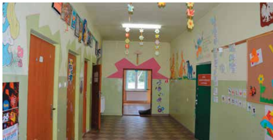
Wnętrze świetlicy przed remontem
