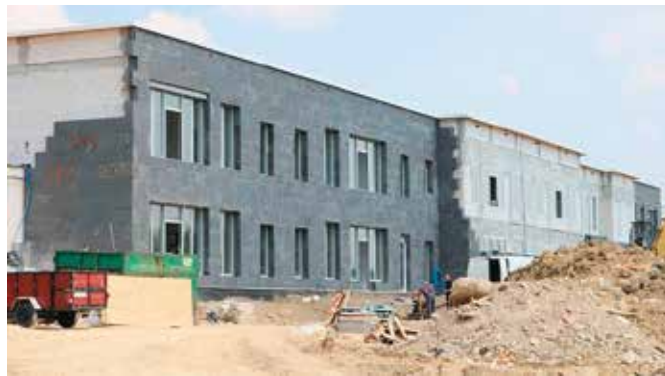
Budowa przedszkola i żłobka w Chęcinach
