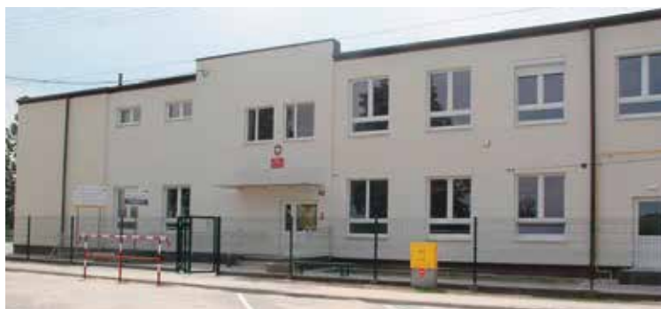
Szkoła w Starochęcinach po kompleksowym remoncie i termomodernizacji
