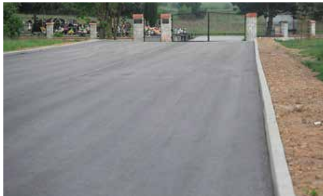
Droga wraz z odwodnieniem i miejscami postojowymi wykonana
