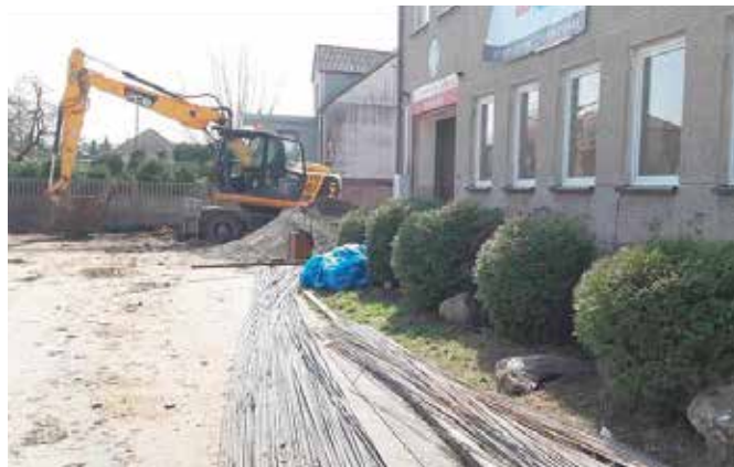
Trwa przebudowa remizy w Siedlcach
