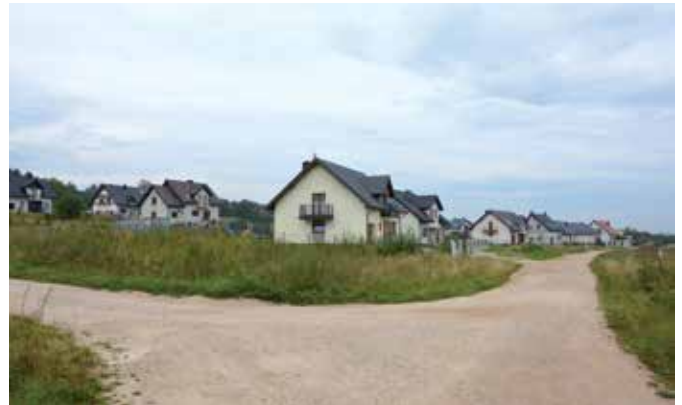
Na Osiedlu w Skibach powstaną drogi i chodniki
