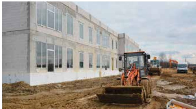
Budynek przedszkola i żłobka już z oknami
