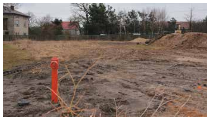
Trwa budowa wodociągu w Wolicy
