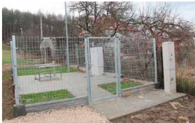
Budowa przepompowni w Chęcinach już zakończona
