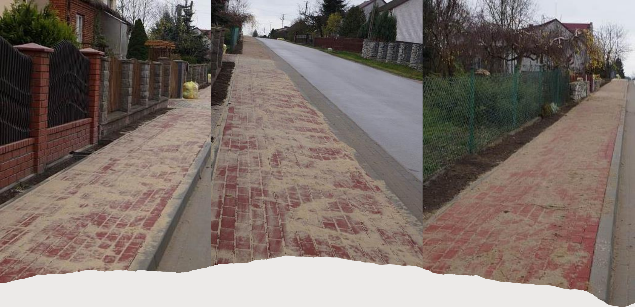
BUDOWA CHODNIKA W KORZECKU
