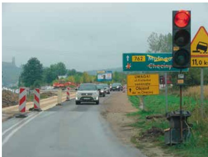
Budowa ronda przy wjeździe do Chęcín wymusza zmianę organizacji ruchu
