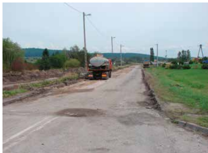
Obecnie trwające prace ruszyły na wysokości Chęciny w kierunku Korzecka
