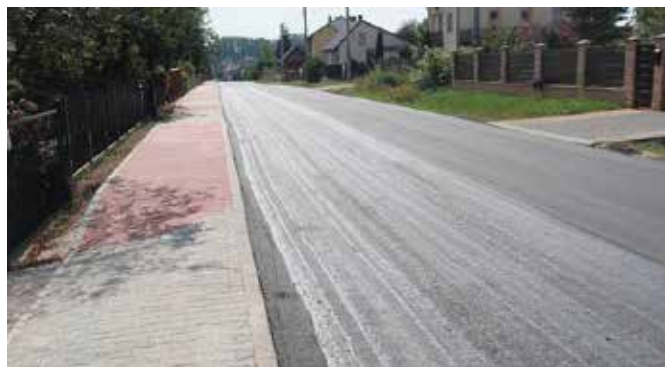
Budowa chodnika w Lipowicy dobiegła końca.
