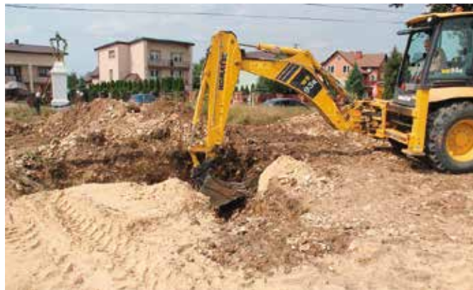
Budowa sieci wodociągowej w Tokarni
