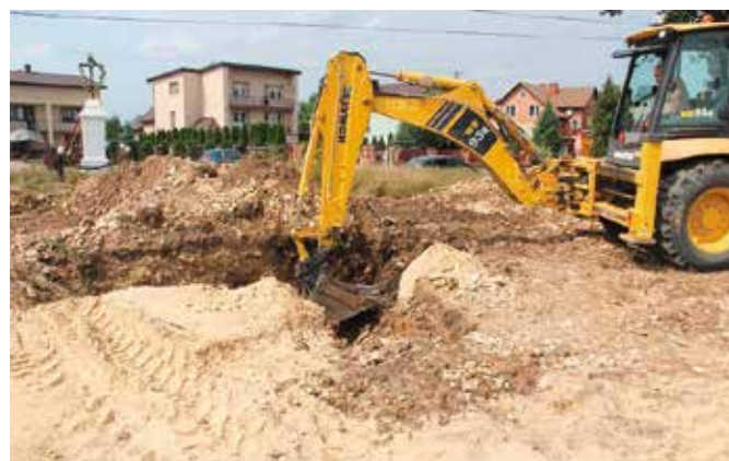
Trwają prace przy budowie kolejnych odcinków sieci wodociągowej
