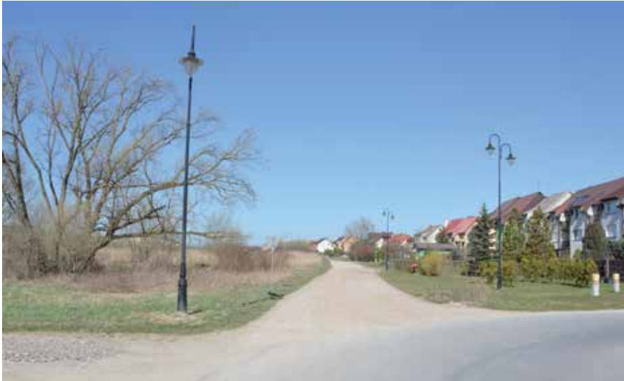
Niebawem Al. Marszałka J. Piłsudskiego zyska nową nawierzchnię
