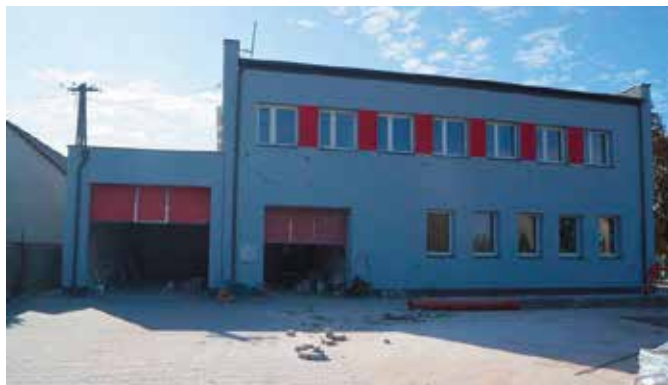
Prace remontowe przy remizie w Siedlcach dobiegają końca
