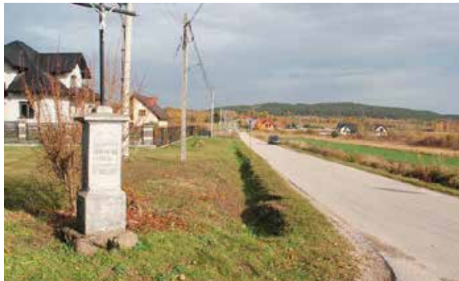
Na tym odcinku planowana jest budowa chodnika w Skibach
