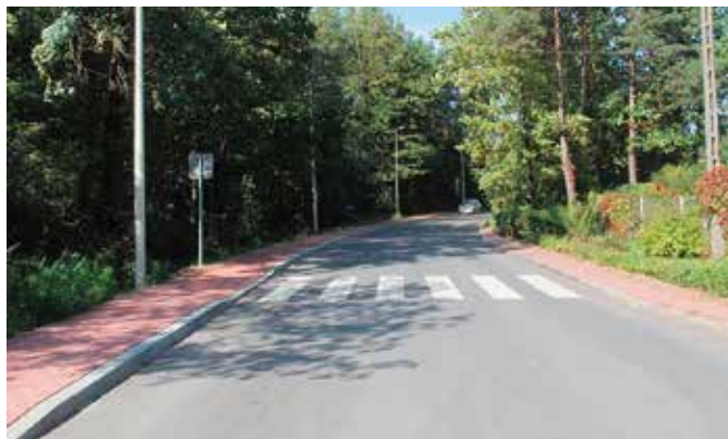
Droga w Czerwonej Górze po modernizacji z nowymi chodnikami
